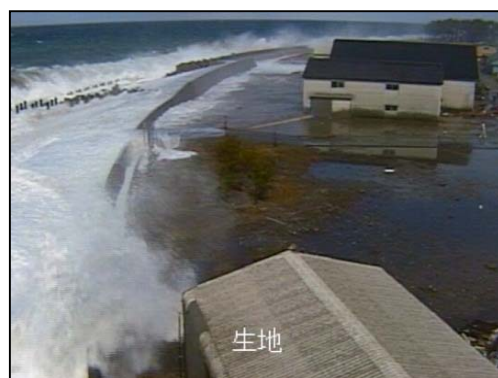
H20.2.24 黒部市生地地先の越波状況
