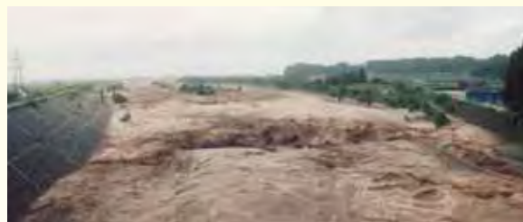
梅雨前線出水状況(愛本地先)
