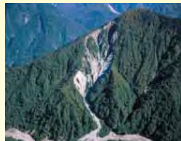
ダム上流の大崩壊地(小黒部谷)
