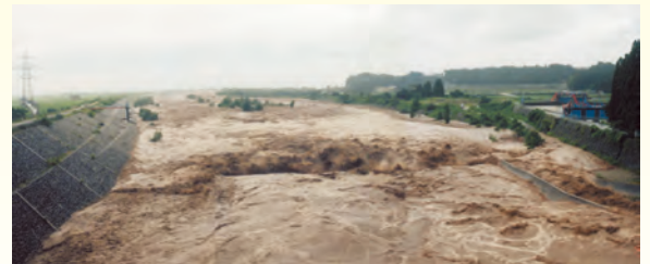
梅雨前線出水状況(愛本地先)
