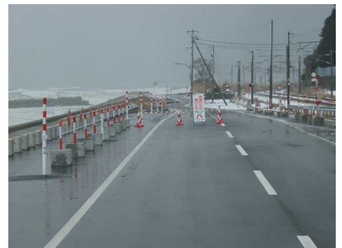
入善朝日線 通行止状況 朝日町元屋敷地区
