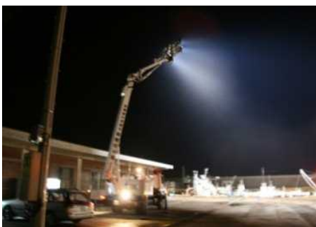
照明車の配置 入善町芦崎地区
