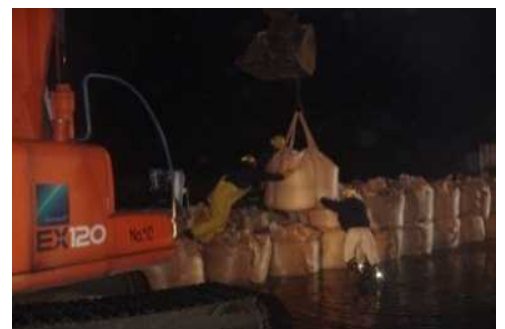
大型土のう設置状況 黒部市生地地区
