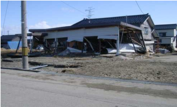
住家の破壊状況 (入善町芦崎地区)
