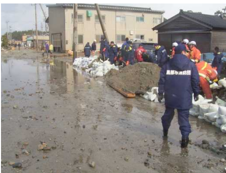
土のう制作・設置状況 黒部市生地地区
