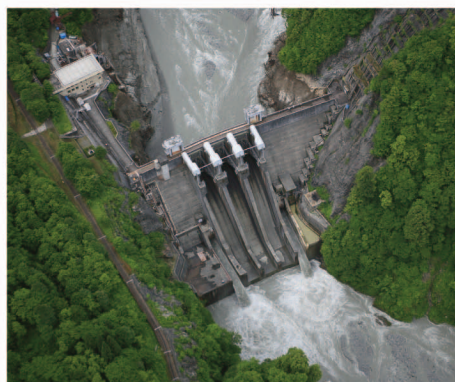
排砂中の出し平ダム(H24)
