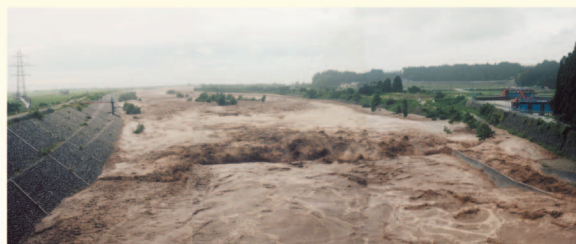
梅雨前線出水状況(愛本地先)
