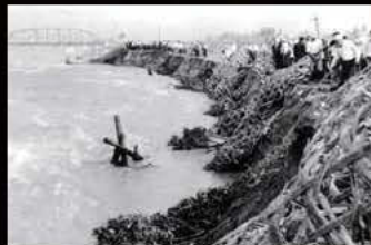
飯野堤一部流出箇所の竹蛇籠工、木流し工、川倉工/昭和28年
