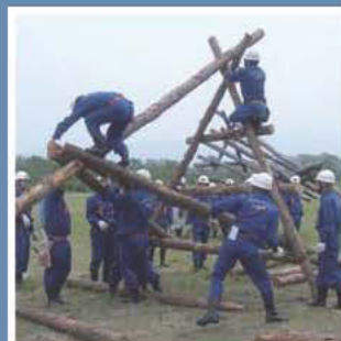
水防工法・川倉工
