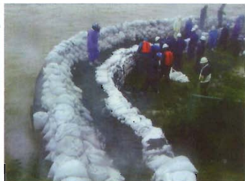
越水防止のため 土のう積み を 行います。
