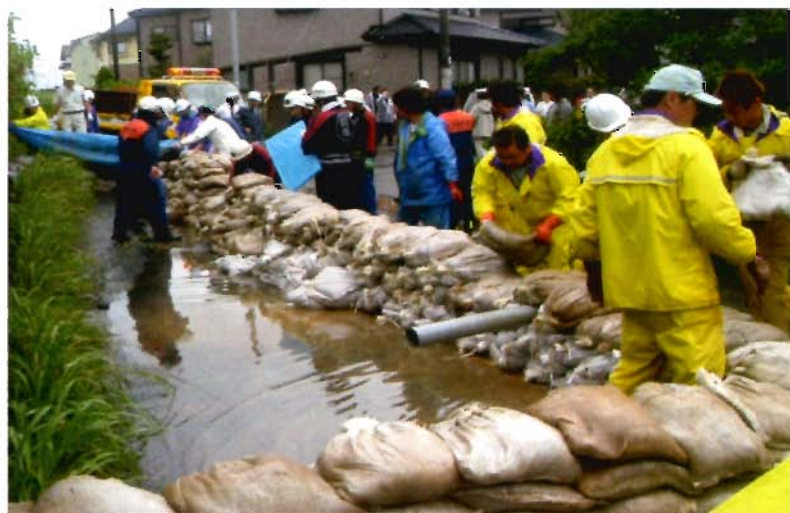
堤防からの水漏れが広がるのを防ぐため、 月の輪工法 を行います。
