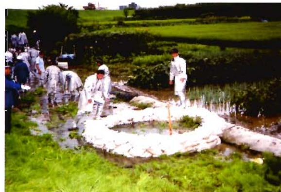
堤内地に噴出する漏水を止めるため 釜段工法 を行います。
