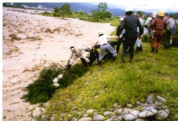
堤防が削られるのを防ぐため 木流し工法 を 行います。
