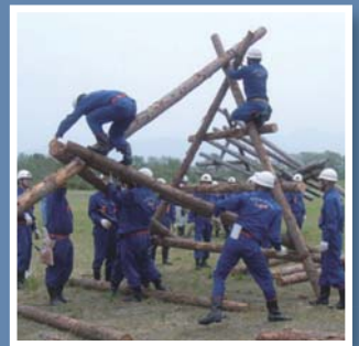
水防工法・川倉工
