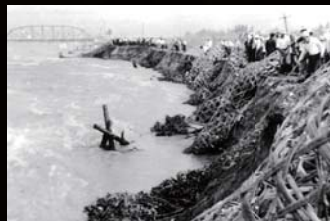
飯野堤欠壊箇所の竹蛇籠工、木流し工、川倉工/S28年
