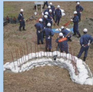
水防工法・月の輪工
