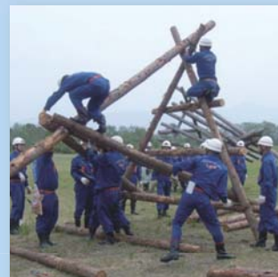
水防工法・川倉工
