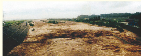
梅雨前線出水状況愛本地先
