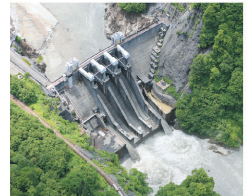
通砂中の出し平ダム(H20)
