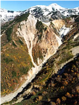
祖母谷崩壊地
