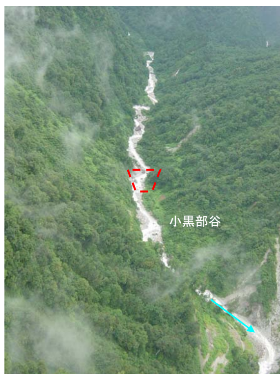
小黒部谷第2号砂防堰堤予定地
