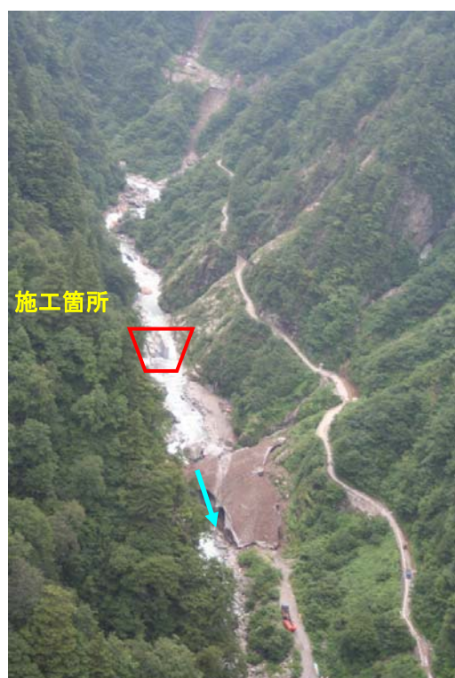
祖母谷下流第2号砂防堰堤
