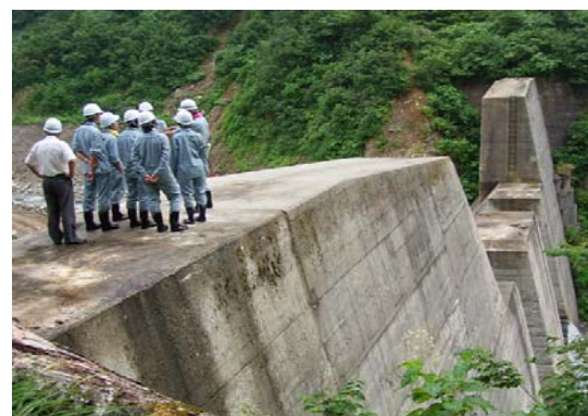
祖母谷第7号砂防堰堤
