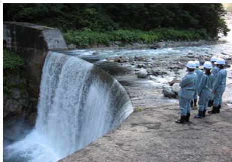
祖母谷第1号砂防堰堤
