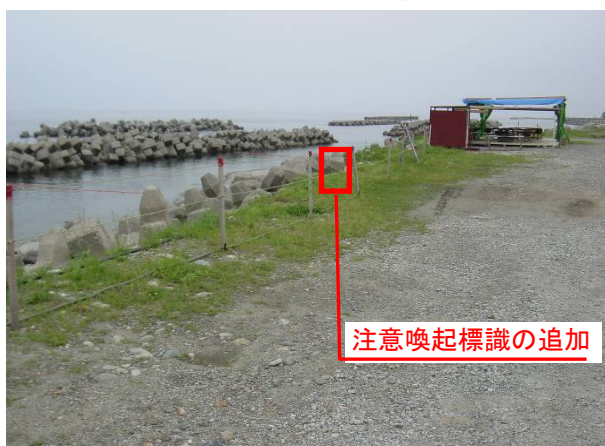
NO, 147+40 消波ブロック被覆土のロープ張り
