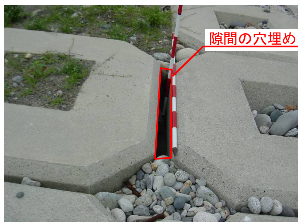
NO, 147+50 斜堤ブロックの隙間(詰め石流出)
