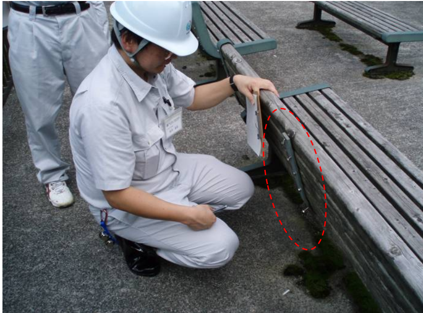
ダム下流展望台 木製ベンチ背もたれの止めネジの緩み・損傷。
