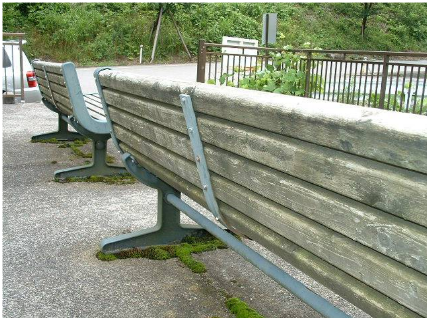
ダム下流展望台 木製ベンチ背もたれ ネジの締付・損傷ネジの交換。
