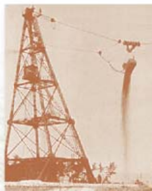
昭和26年から42年まで、天井川対策としてタワエキスカベータによる大規模な河床掘削が実施された。
