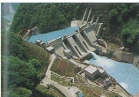
宇奈月ダムは、洪水調節・水道水の供給・発電を行う多目的ダム。流入土砂が極めて多いため、直轄ダムでは初めての排砂設備を備えている。
