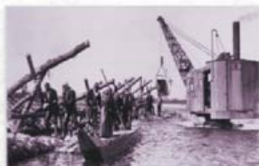
昭和12年、直轄事業初年の大布施堤の改修。蒸気ドラグラインによる掘削と、人力を主にした川倉の据え付けの様子。
