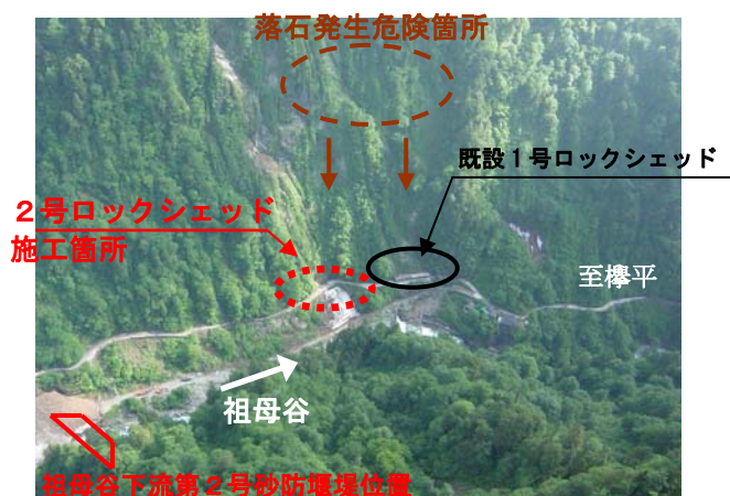
祖母谷下流第2号砂防えん堤
