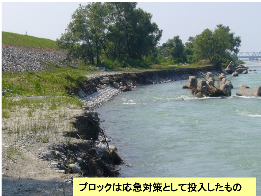
黒部市飛騨地先【河岸欠壊】黒部川
