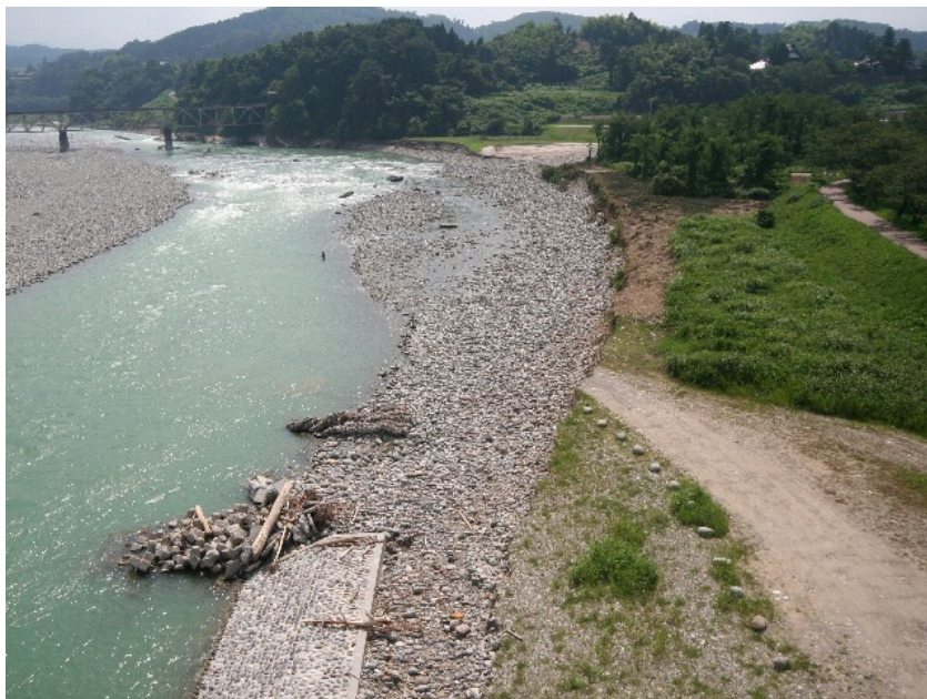
富山市八尾町西神通地先【河岸欠壊】神通川
