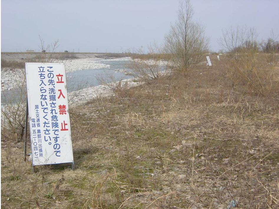
12. 4k付近 低水護岸天端の注意看板
