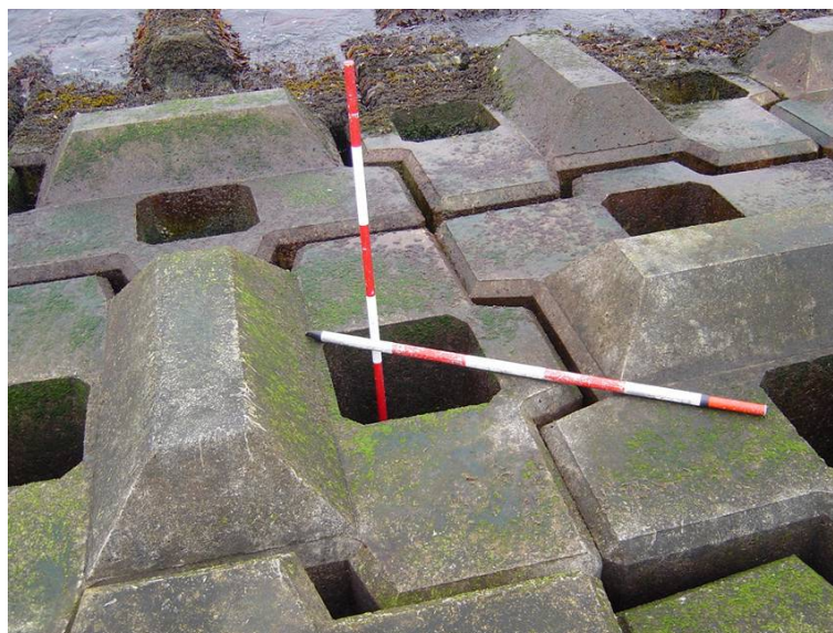
NO, 139+50 ブロック基礎割石の流出状況
