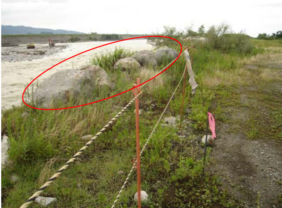
右岸12.3k付近 低水護岸上流高水敷の河岸洗掘
