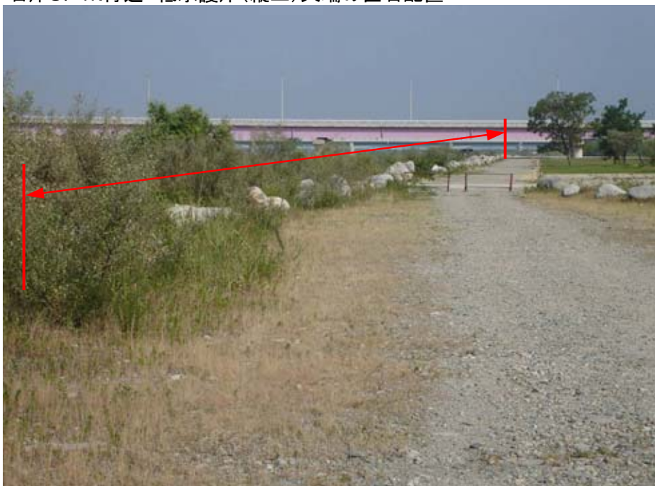
右岸8.4k付近 低水護岸(縦工)天端の巨石配置
