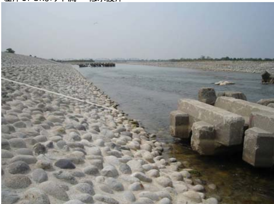
左岸5.8kより下流 低水護岸
