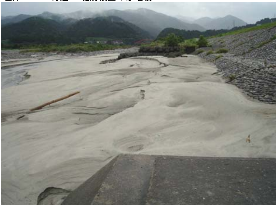
左岸12.1k付近 堤防根固の砂堆積
