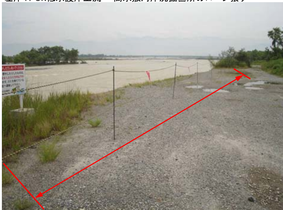
左岸1.6k低水護岸上流 高水敷河岸洗掘箇所のロープ張り
