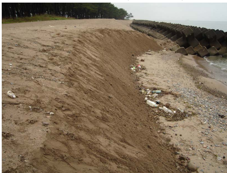
大島海岸 養浜法面法人力整形(消波工開口部)
