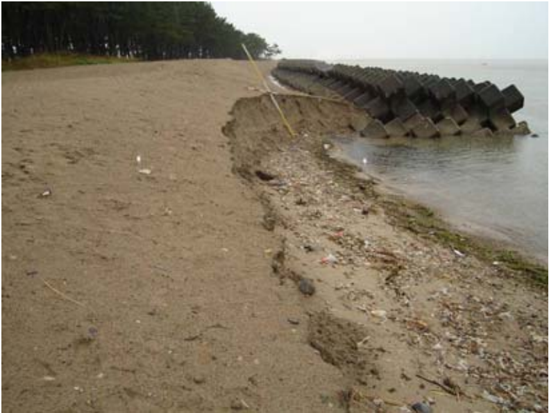
NO. 15付近 消波工開口部養浜侵食状況
