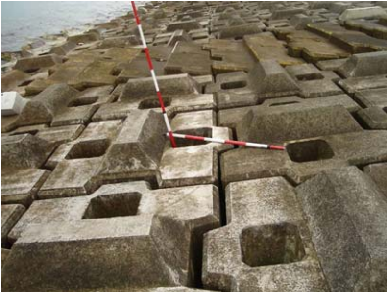
NO. 138+70 緩傾斜堤ブロックの穴
