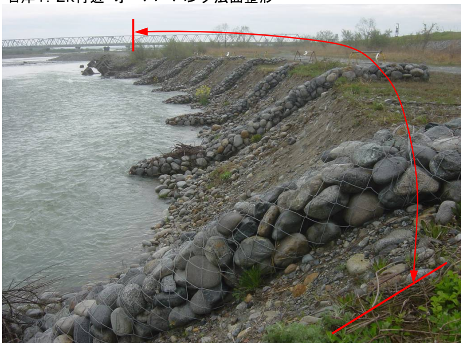
右岸1.2k付近 オーバーハング法面整形
