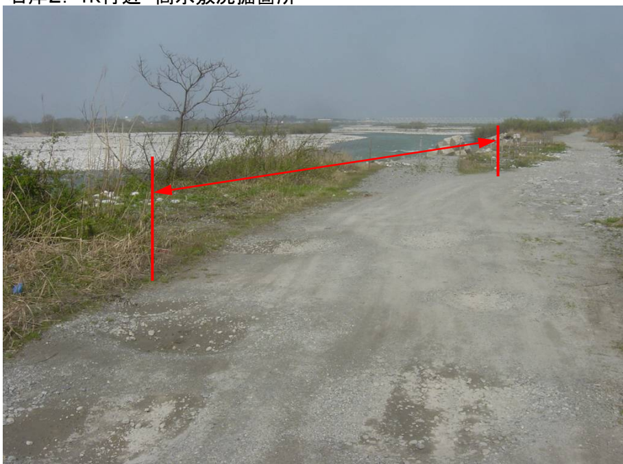
右岸2.4k付近 高水敷洗掘箇所
