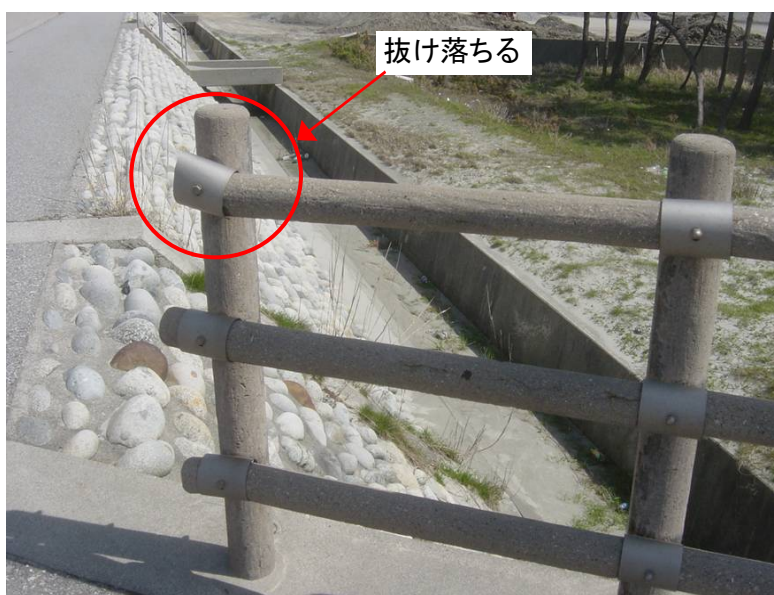
NO. 81付近 転落防止柵(脱落)
