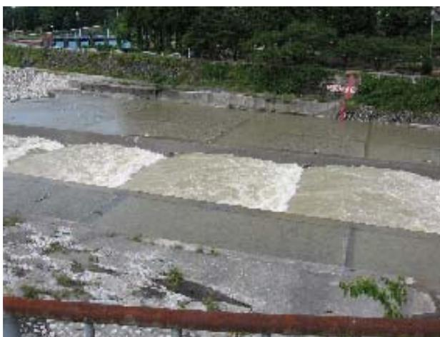
これは、川の勾配を緩やかにすることで水の勢いを減らすことができる愛本床止工です。川の流れによるコンクリートの摩耗を防ぐために、要所にゴムと鉄板を使用した特殊な板を設置しています。
