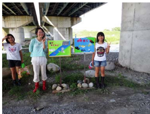
北陸自動車道橋梁下
