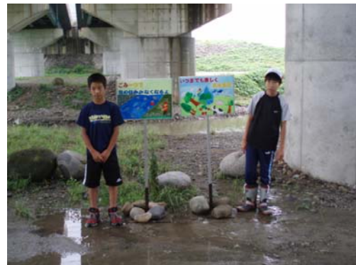
北陸自動車道橋梁下
