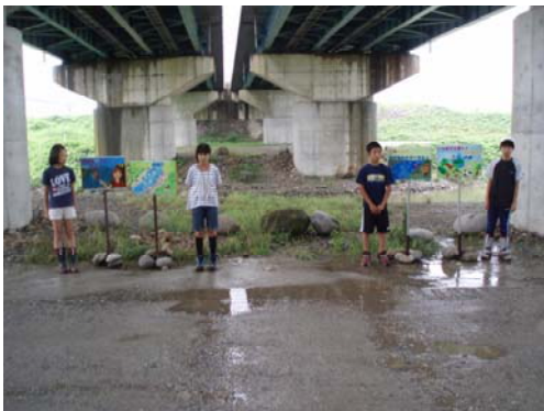
北陸自動車道橋梁下
