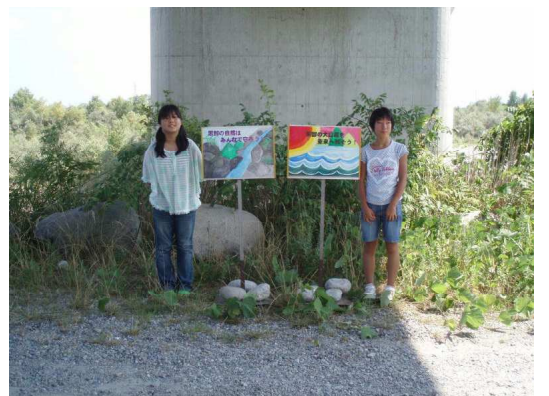
北陸新幹線橋梁下
