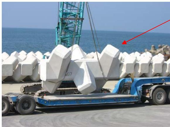
これは離岸堤を並べている様子です。このブロックは1個24トンの重量があるそうです。この時は行わなかったのですが、後に大型船にブロックを乗せて、離岸堤を海の中に沈め、組み立てるそうです。
