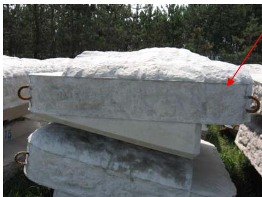
これは緩傾斜堤を構成するブロックのです。一つ一つ、寸法や厚さを入念に測り、証明写真も撮っていました。このブロックを全て組み合わせて緩傾斜堤が完成するのです！！
