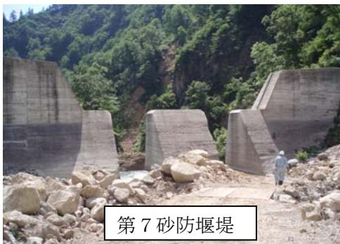
これは砂防堰堤です。砂防堰堤とは、土砂をせき止め、下流への流出を防ぐための構造物です。この砂防堰堤は従来のものとは違い、スリットと呼ばれる隙間によって細かい砂のみを下流に流すことができ、大きな土砂をせき止めることができる仕組みになっています。
