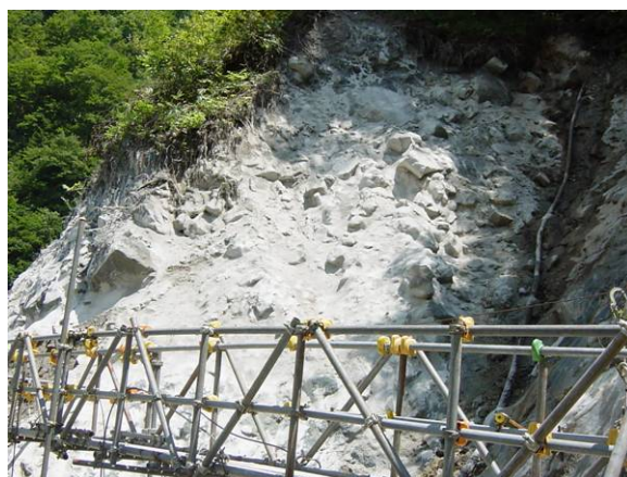
7月に起きた土砂崩れ
