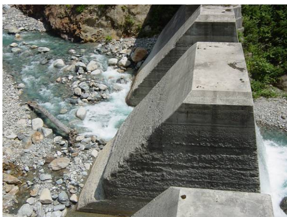
祖母谷最上部の砂防堰堤
