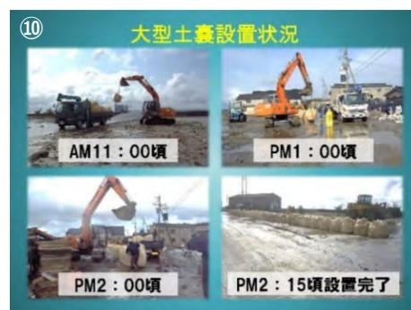
しかしながら、設置後の午後2時25分頃の3回目の高波により、大型土嚢が押し流されてしまい、大量の海水が再び町内に押し寄せてしまいました。急遽一段目二列、二段目一列の二段積み追加補強対応をすることになりました。また少しでも土嚢の重さを重くするため、砕石を詰めて対応することとしました。
