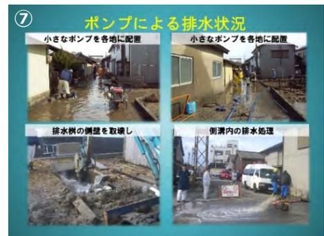
また排水は流末の排水箇所を安定的に確保するため、排水枡の側壁を取り壊し、開口部を広くすることや、側溝内の排水くみ上げ、土砂除去をしながらの作業となりました。排水作業を行うとともに、小型土嚢設置を黒部消防所及び消防団や地元の皆さんと共同作業で行いました。(スライド⑧)
