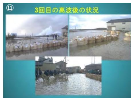
3回目の高波後、追加の土嚢づくりと設置を行いました。冬期間のため日没になるのも早く照明をつけての作業となりました。また気温も下がり雪も降ってきて、大変寒い中での作業となりましたが、午後7時頃になんとか設置が終わりました。最終的には、大型土嚢製作、運搬、設置242個を実働7時間で行いました。（スライド⑫）
