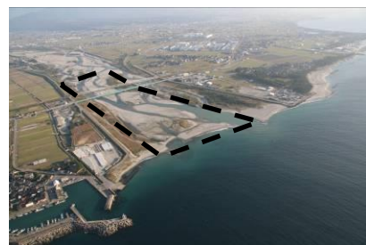
写真 3-14 河口の土砂堆積状況
