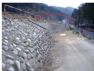
写真 3-10 左岸 13.2k の堤防
