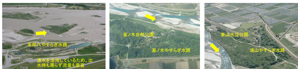
写真 3-4 霞堤を利用したやすらぎ水路
