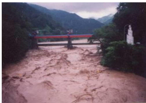
写真 3-1 愛本狭窄部における洪水時の流れ（平成 7 年（1995 年）7 月洪水）
