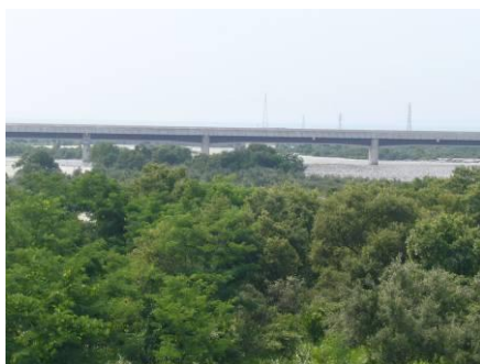
写真 3-15 高水敷に繁茂した樹木群
