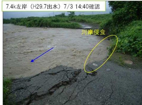
約18mの河岸侵食が発生 ブロック投入による応急復旧を実施
