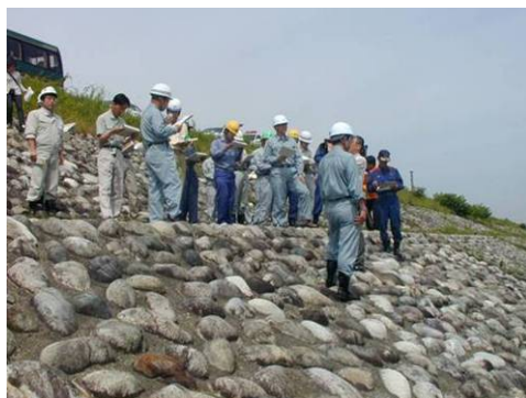
写真 3-22 関係機関による巡視・点検
