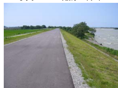
写真 5-9 堤防天端の舗装
