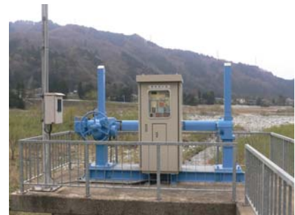
写真 5-11 河川管理施設の点検（樋管）
