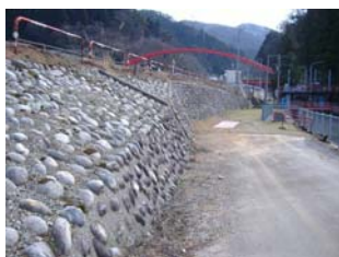
写真 3-11 左岸 13.2k の堤防
