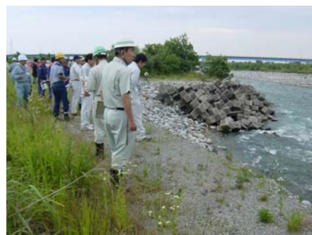
写真 5-4 関係機関による河川の 巡視点検（重要水防箇所）
