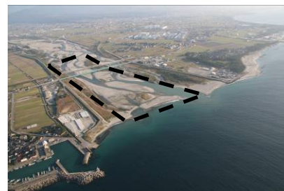
写真 3-15 河口の土砂堆積状況
