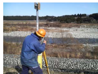
写真 5-5 定期横断測量
