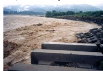
写真 5-6 洪水後の状況把握 (平成 10 年 7 月洪水)
