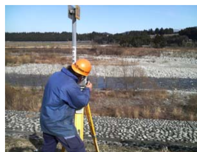
写真 5-5 定期横断測量
