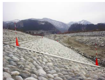
写真 5-10 護岸の補修
