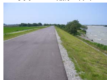
写真 5-9 堤防天端の舗装
