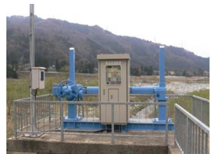
写真 5-11 河川管理施設の点検(樋管)
