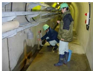
写真 5-14 ダム堤体・放流設備の点検
