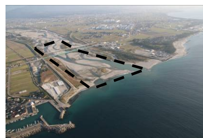
写真 3-15 河口の土砂堆積状況
