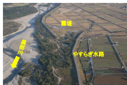
写真 3-4 霞堤を利用したやすらぎ水路（浦山）
