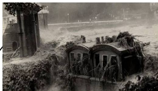
昭和 44 年 8 月洪水 愛本堰堤における流況
