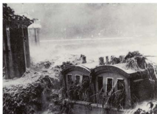
●冠水した愛本えん堤
