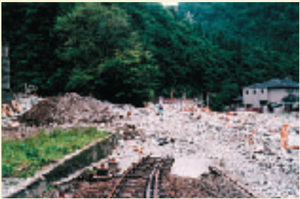
平成7年7月黒部峡谷鉄道猫又駅付近の被災状況
