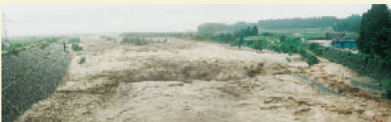
平成7年7月梅雨前線出水状況愛本地先
