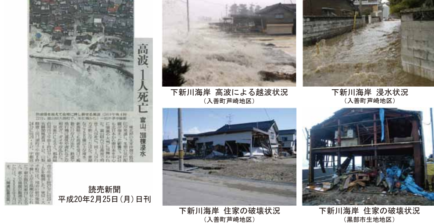
下新川海岸 高波による越波状況 (入善町芦崎地区) 下新川海岸 浸水状況 (入善町芦崎地区) 下新川海岸 住家の破壊状況 (入善町芦崎地区) 下新川海岸 住家の破壊状況 (黒部市生地地区)
