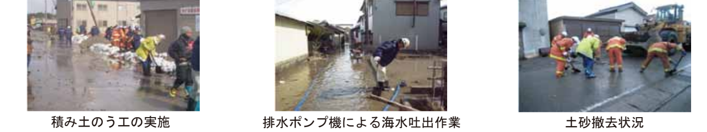
積み土のうの実施 排水ポンプ機による海水吐出作業 土砂撤去状況
