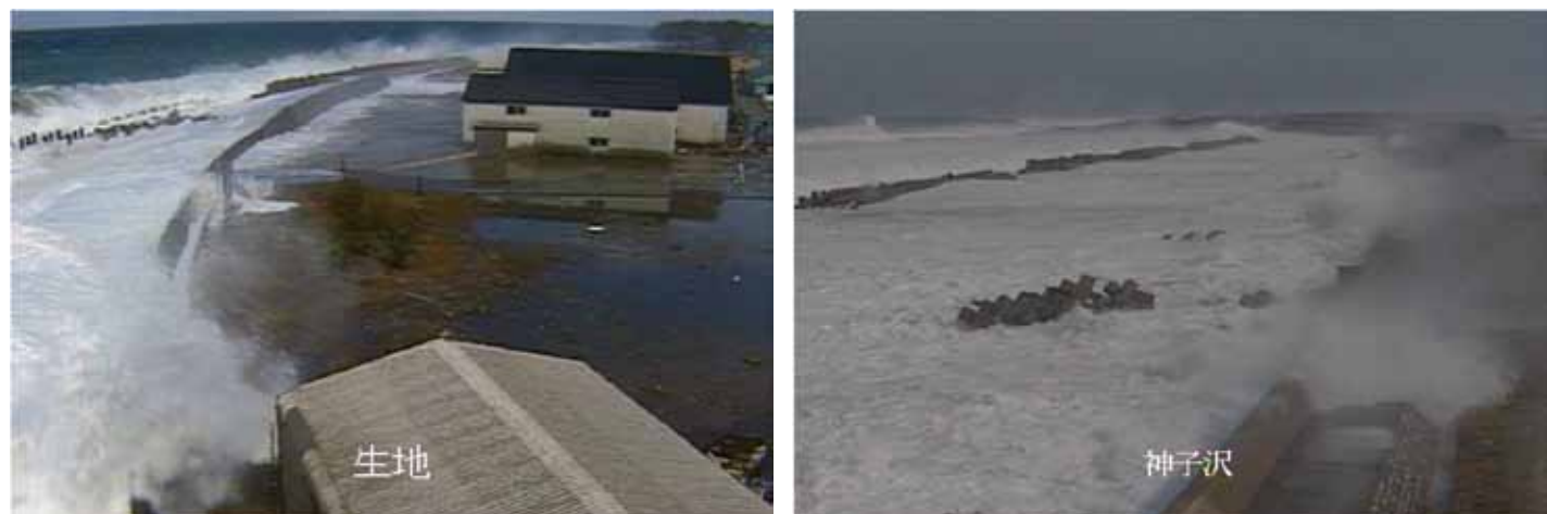
高波による越波 (生地CCTV映像 平成20年2月24日 11:36)
