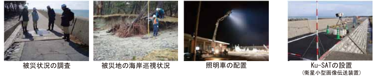
被災状況の調査 被災地の海岸巡視状況 照明車の配置 Ku-SATの設置 (衛星小衛星画像伝送装置)
