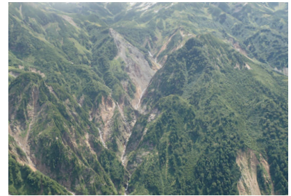
祖母谷崩壊地
