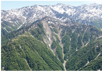
不帰谷崩壊地
