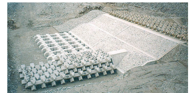
根継ぎ護岸工
