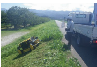
石張護岸の堤防除草
