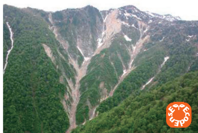
不帰谷崩壊地
