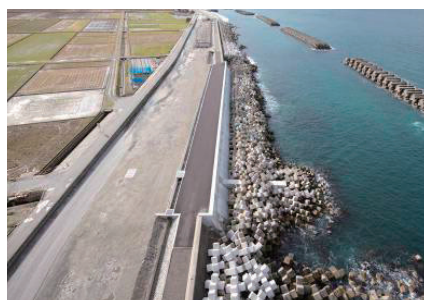
堤防改良（入善町）
