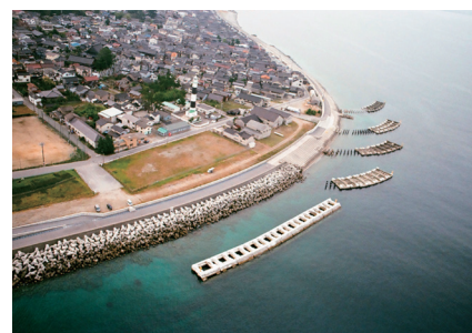
透過型有脚式突堤（黒部市）
