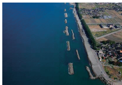
離岸堤（朝日町）
