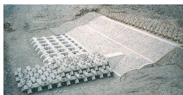
根継ぎ護岸工
