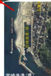
宮崎漁港(県) (平成17年10月撮影) (昭和27年7月外郭施設建設開始)
