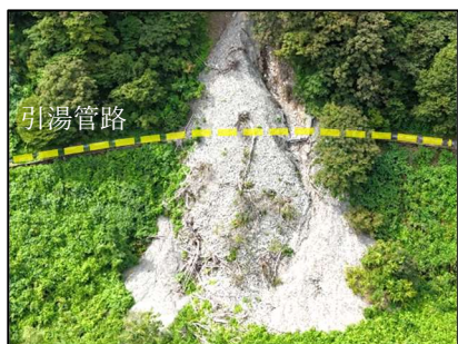
写真-1 崩落地（傾斜 1:0.95）
