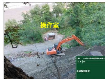
写真-9 土砂除去作業
